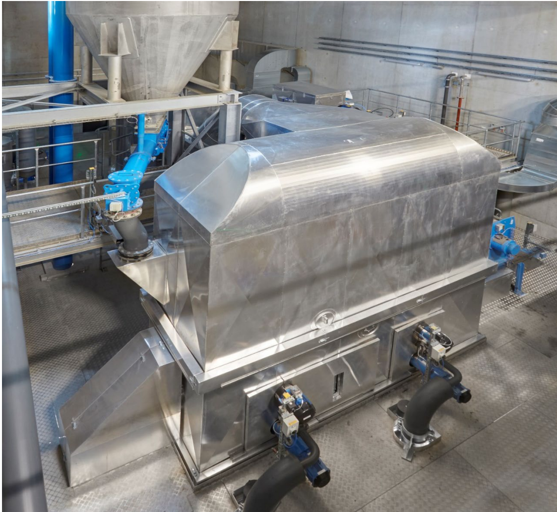
Wirbelschichttrockner der ara bern
